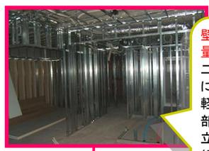
壁/間仕切壁<軽量鉄骨下地>…二重床完了後、床に位置出しを行い軽量鉄骨下地で、部屋の間仕切りを立て天井の下地を組みます。
