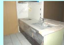
キッチン据付…システムキッチンを据付、給排水の配管を接続します。
