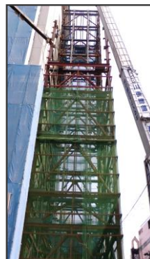
鉄骨建方の様
