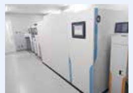
最新型RO装置、 透析液供給装置ほか
